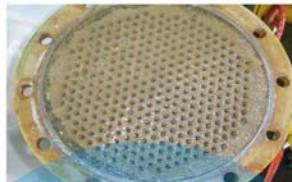
油田稀油站冷却器为油水换热系统，结垢严重，必须定期拆开清洗，严重影响正常运行，安装量子管通环后，冷却器内的水垢得到清除，表面干净，管路畅通。
